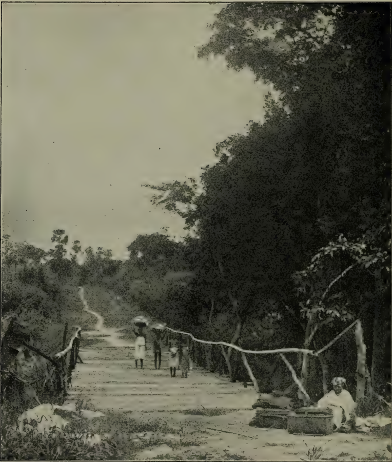
Eine von der Regierung angelegte Brücke.
